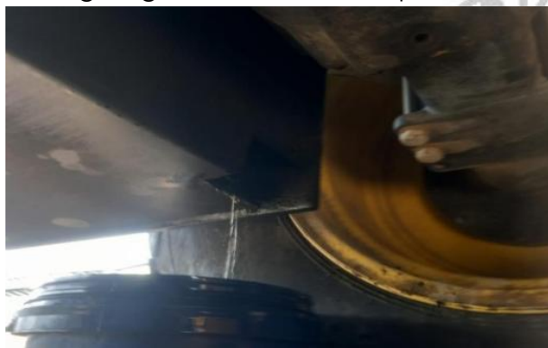
Corregir fuga de aceite del niple de salida del tanque hidráulico
