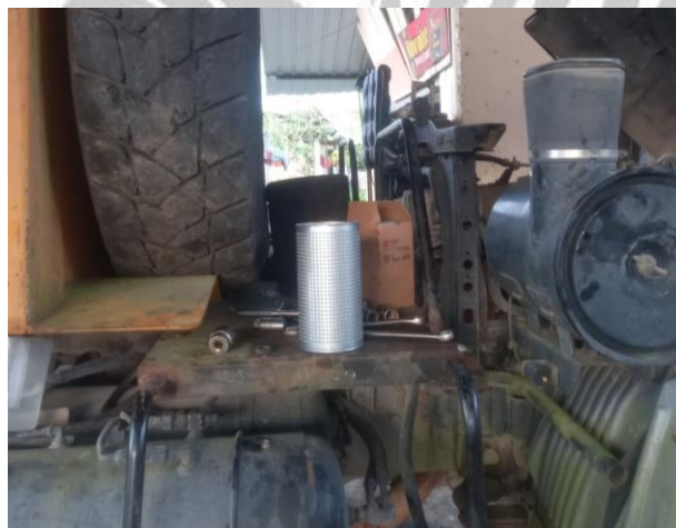
Remplazar filtros de aceite de motor primario, secundario
